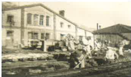
Geleisearbeiten beim Bahnhof Chur
