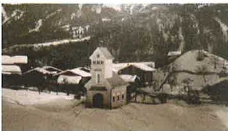
Bedienungshäuschen über dem Wasserschloss in Lügen
