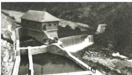
Wasserfassung und Ablagerungsbecken Pradapunt/Molinis
