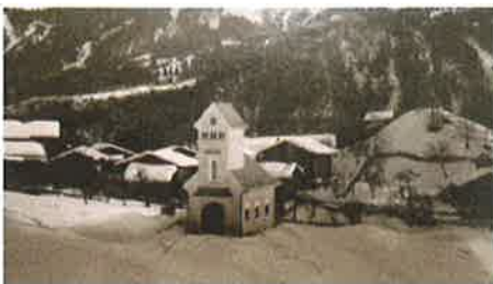
Bedienungshäuschen über dem Wasserschloss in Lügen
