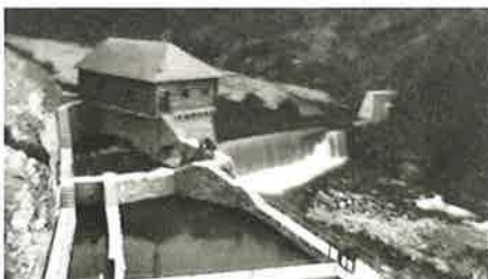
Wasserfassung und Ablagerungsbecken Pradapunt/Molinis
