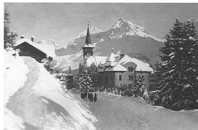
Verwaltungsgebäude im Winter 1910
