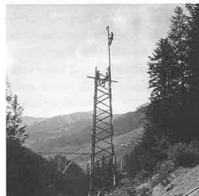
Bau Gittermast-Leitung nach Langwies (1930/31)
