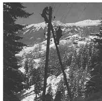
Reparatur 10 kV-Talleitung beim Durabus (1984)
