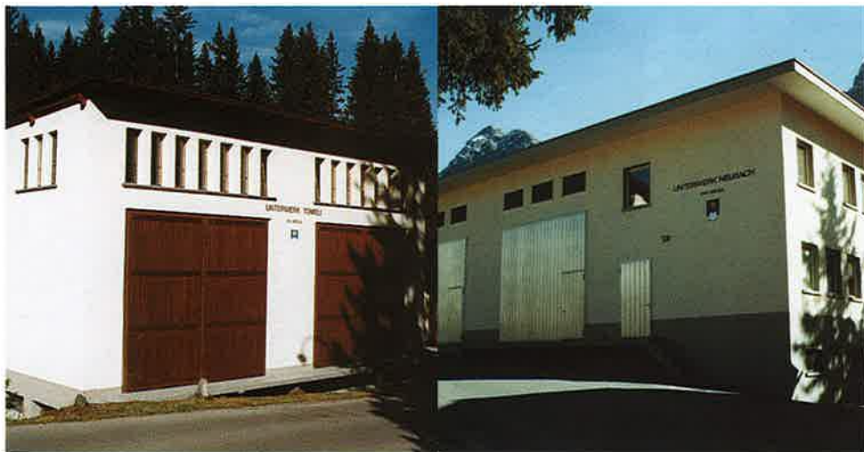
Unterwerke Tomeli und Neubach nach der Renovation 1997
