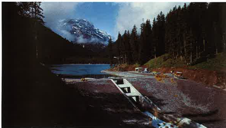
Stauwehr Isel kurz vor der Fertigstellung 1968
