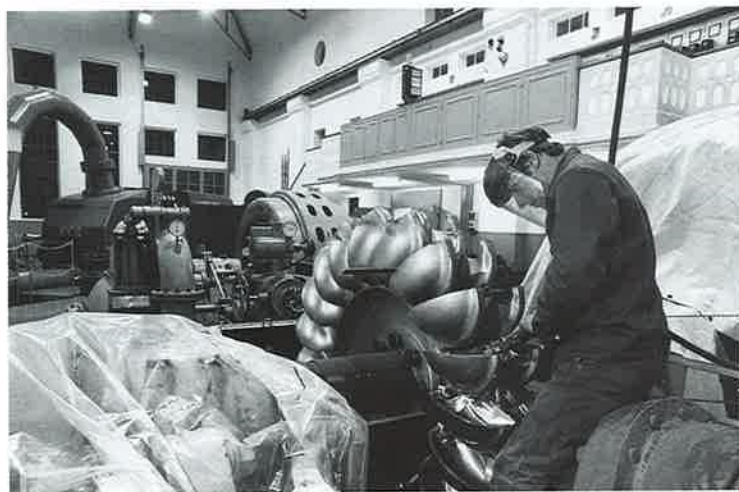
Revision Turbine Maschine 3, Kraftwerk Lünen; Schleifen der Schaufelräder
